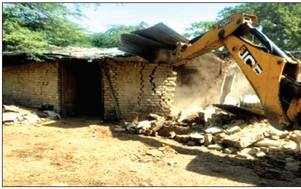
अवैध निर्माण को गिराता बुलडोजर
