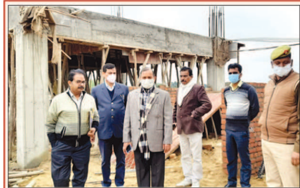
निर्माणधीन भवनों का निरीक्षण करते नोडल अधिकारी
