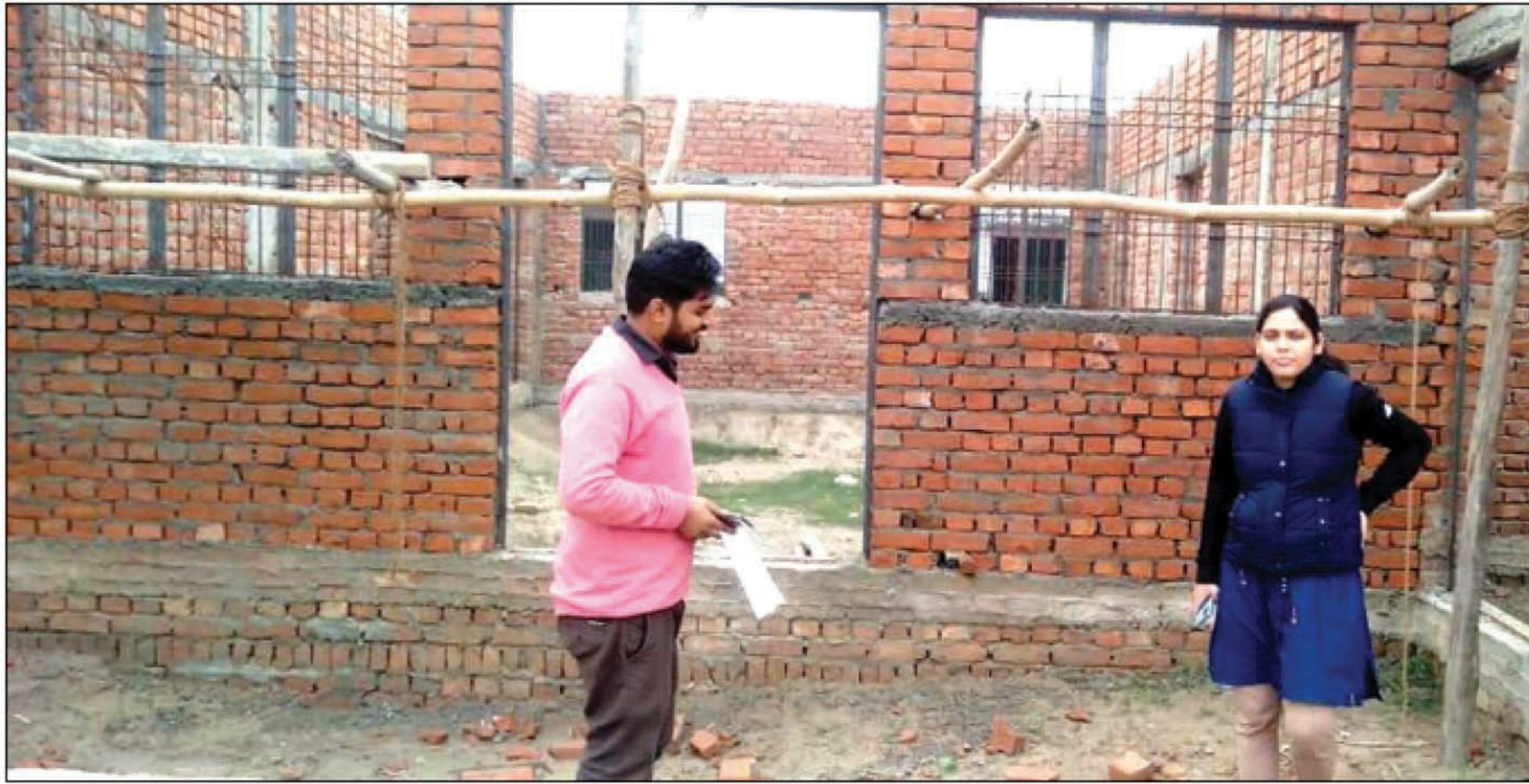
निमाणाधीन पंचायत भवन का निरीक्षण करती बीडीओ समा सिंह
