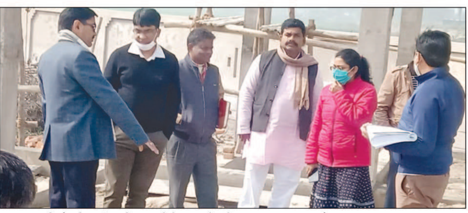
निर्माणाधीन ब्लॉक परिसर का निरीक्षण करते कपिल कुमार उपायुक्त श्रम रोजगार प्रयागराज व अन्य
