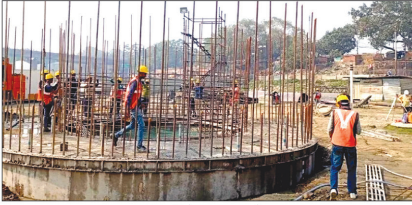
पुल निर्माण का चल रहा कार्य
