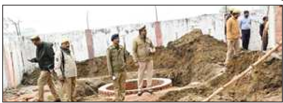
थाने की निर्माणाधीन इमारत का निरीक्षण करते एसपी।
