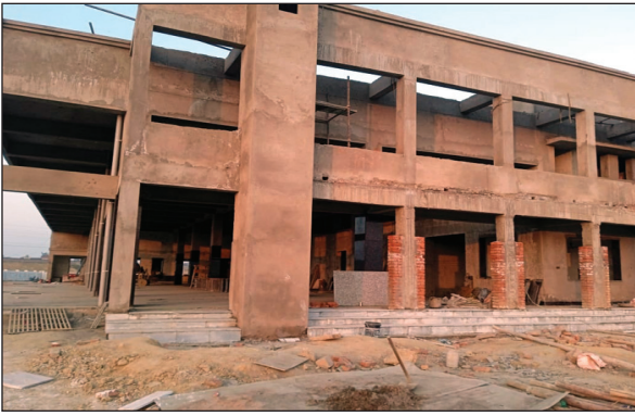
निर्माणाधीन रोडवेज भवन
