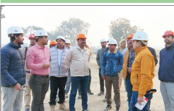
निर्माणधीन मेडिकल कॉलेज का निरीक्षण करते जिलाधिकारी
